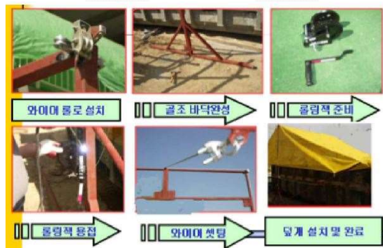
그림1: 건설현장의 이동형 비산먼지 방지 덮개의 제작과정도
